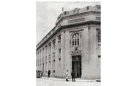
16. Edificio de la Sanidad
