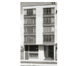
20. Edificio Jorge Bejarano
