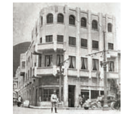
18. Edificio de Renta Calle 19
